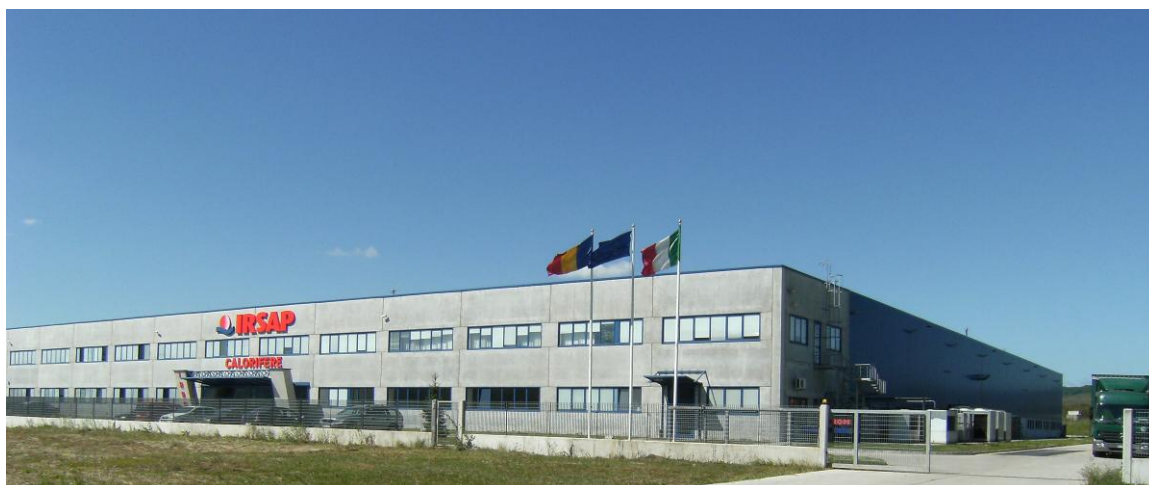
Figura 38. SC IRROM SRL - Fabrica de calorifere din Iclod
